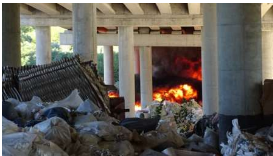
Фигура 1: Горящи отпадъци в подмостовото пространство при река Джерман на 62-ри КМ на „АМ Струма“ – снимков материал от архивите на БГНЕС
