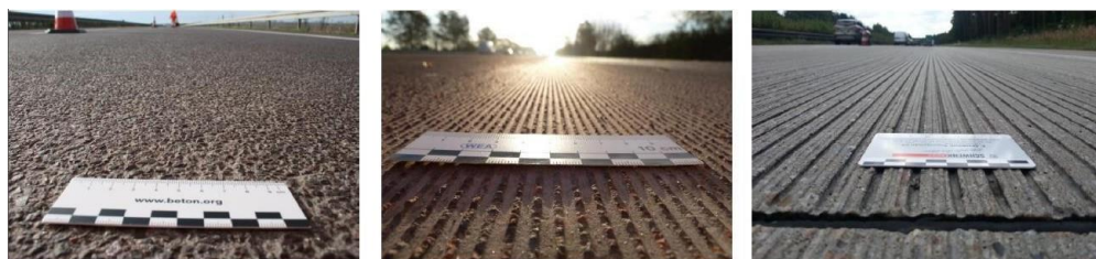
Фигура 7 Примери за различни повърхностни обработки на бетонови настилки.
