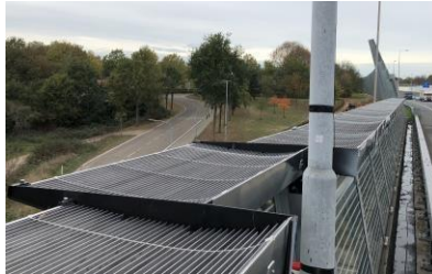
Фигура 3 WhissTop, монтиран върху шумозащитни стени
