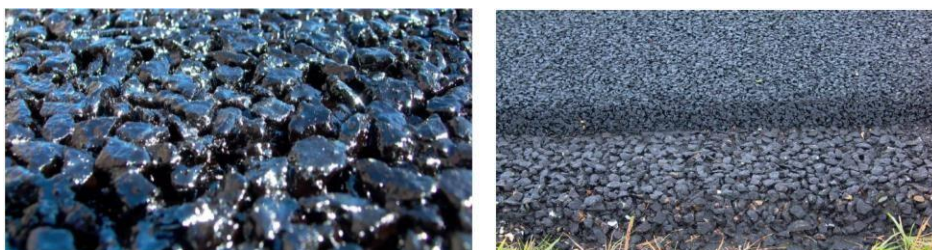
Фигура 6 Снимка отблизо на току-що положен порьозен асфалт (ляво); Снимка на два положени пласта порьозен асфалт (дясно)
