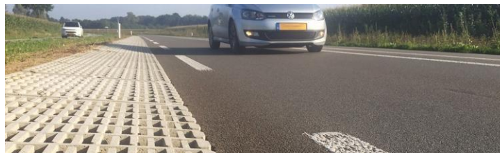
Фигура 1 Участък с монтирани бетонови елементи, които разсейват шума.
