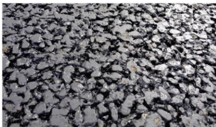
Фигура 5 Снимка отблизо на току-що положен шумонамалящ сплит-мастик-асфалт. Кухините по повърхността на настилката помагат за намаляване на шума, генериран от изпомпвания въздух.
