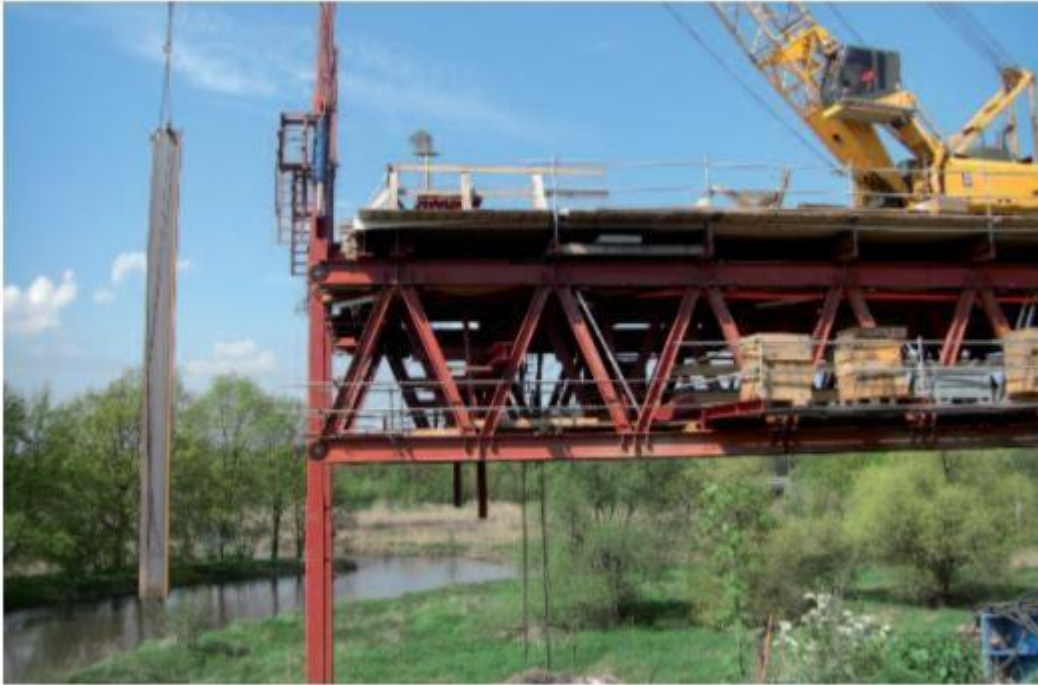
Фиг. 2 Строителство на Виадукт Saale – Elster – Методът “Vorkorfbau”
