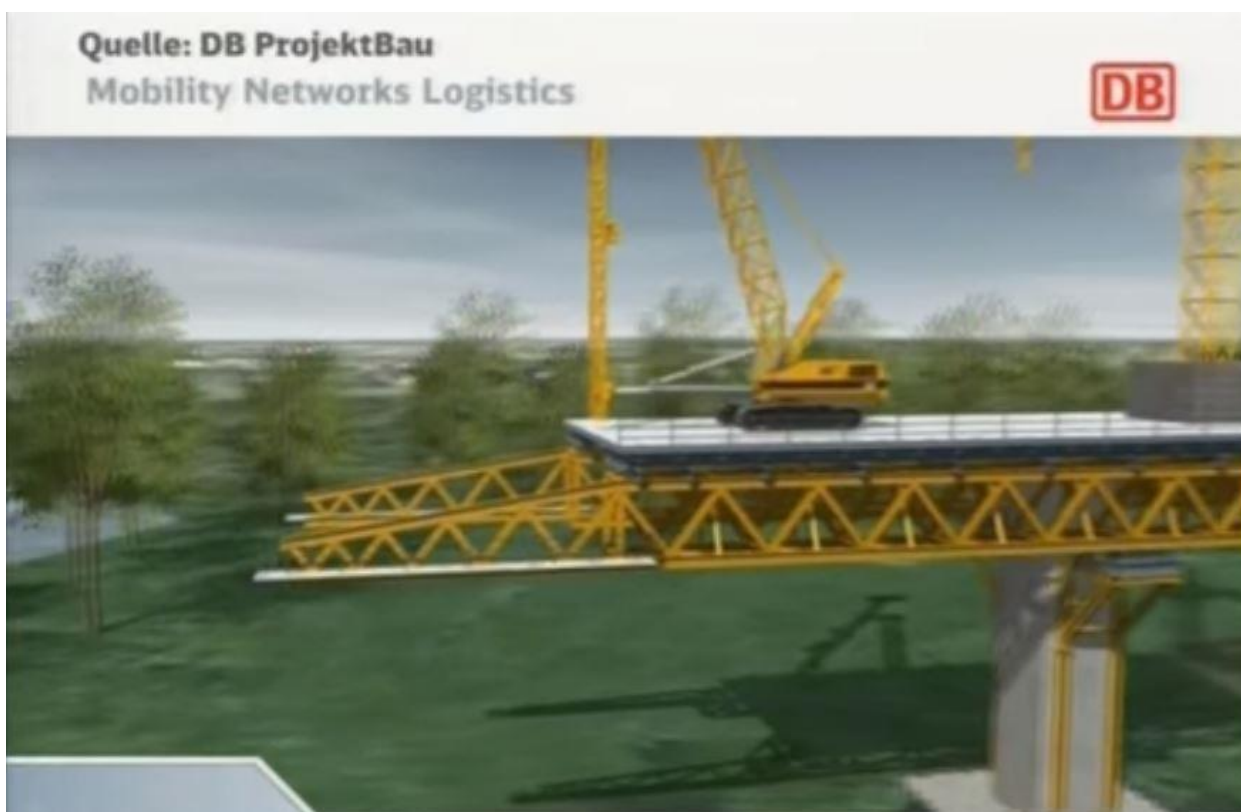
Фиг. 1 Строителство на Виадукт Saale – Elster – Методът “Vorschubbau”
