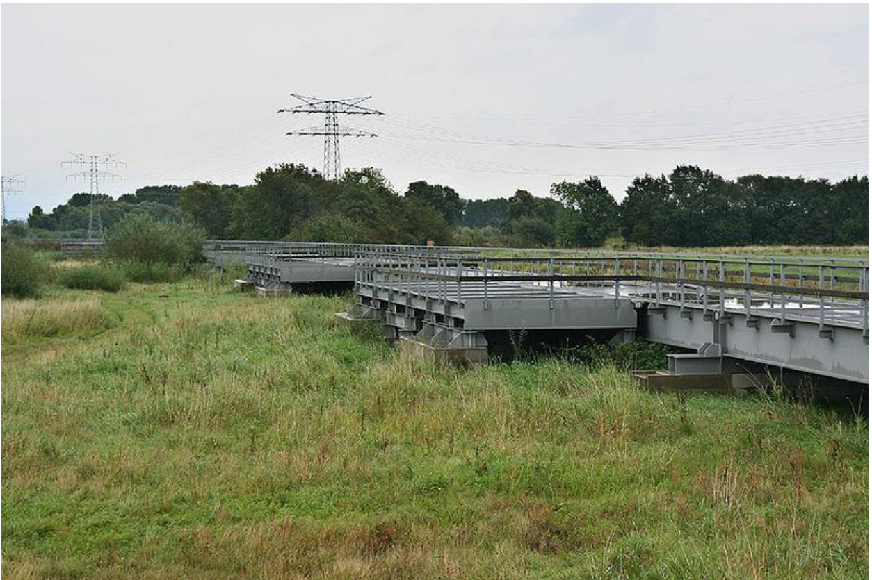
Фиг. 3 Строителство на Виадукт Saale – Elster – Временен път в защитена територия
