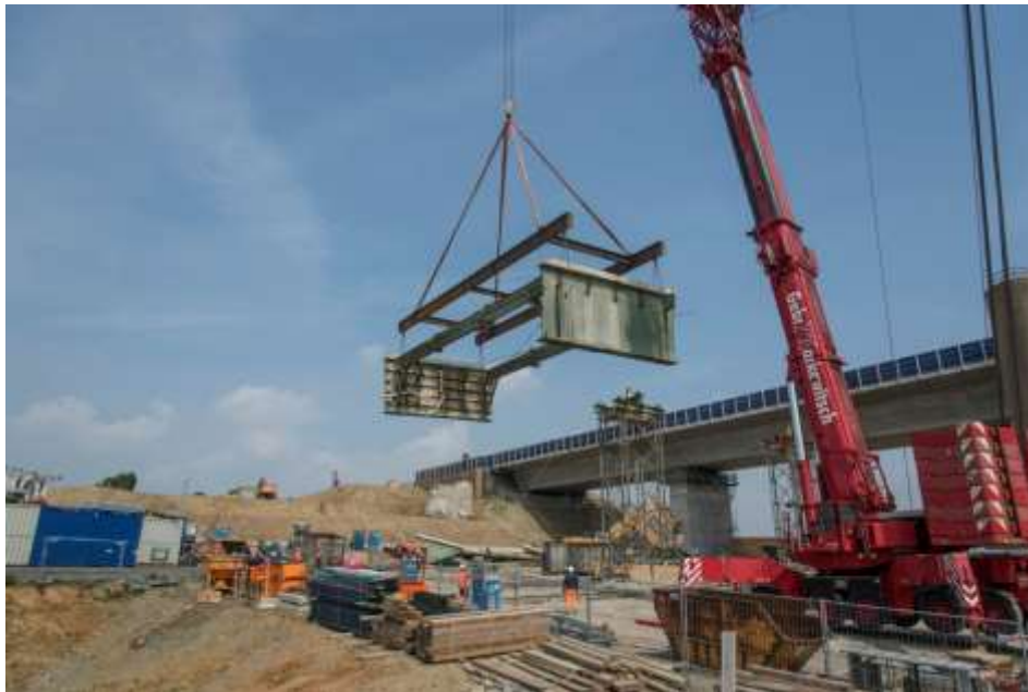
Фигура 7: Отстраняване на 10-метров елемент посредством траверса
